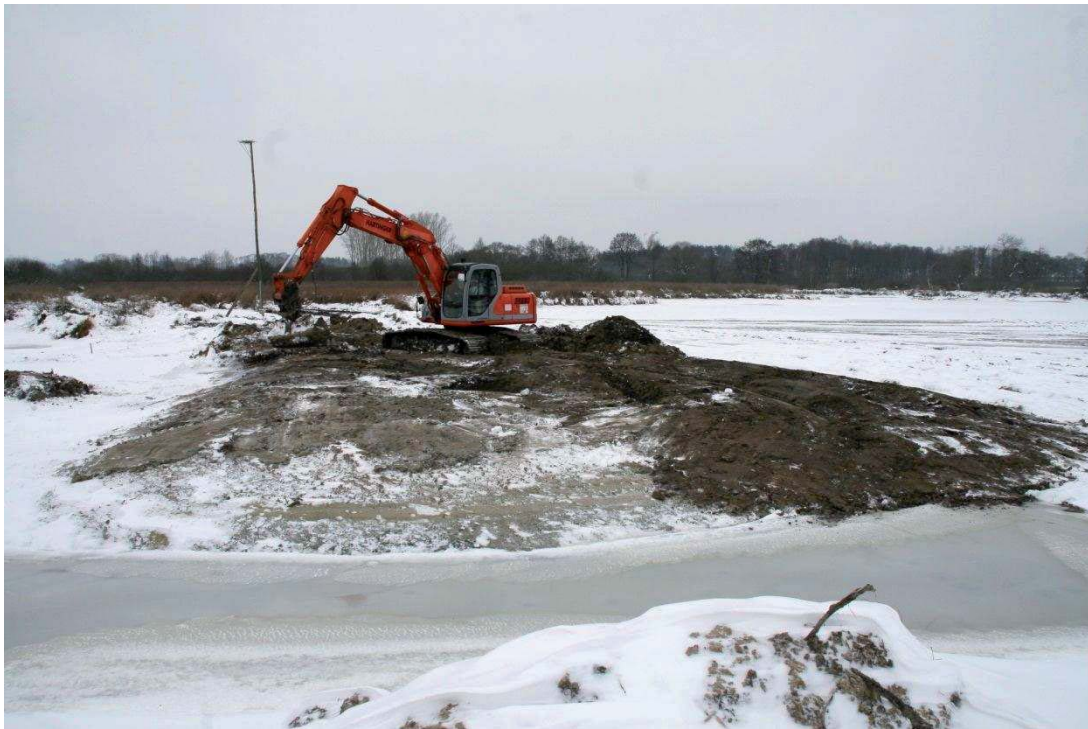
Kettendumper und Bagger im Einsatz.
