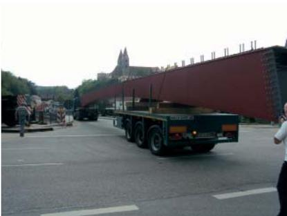
Anlieferung und Versetzen der bis zu 36 m langen Stahlträger.
