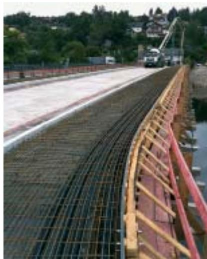
Der Überbau der Brücke wird komplett in der Behelfslage erstellt...
