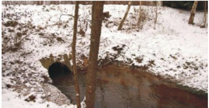
Die Messstelle erfasst die Wassermengen am Auslauf des Neubäuer Weihers und wird zusätzlich beaufschlagt durch das Niederschlagswasser der Straßenentwässerung der „Seestraße“ in Neubäu.
