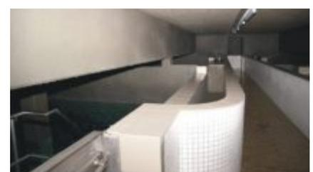
Wasserkammern wurde mit Hochdruckwasserstrahl abgetragen und durch eine zementgebundene Beschichtung in mehreren Lagen ersetzt. Die Maßnahme wurde im April 2009 abgeschlossen. Der Hochbehälter Roding wurde vom Werkausschuss der Kreiswerke Cham nach Abschluss der Sanierungsarbeiten besichtigt.
