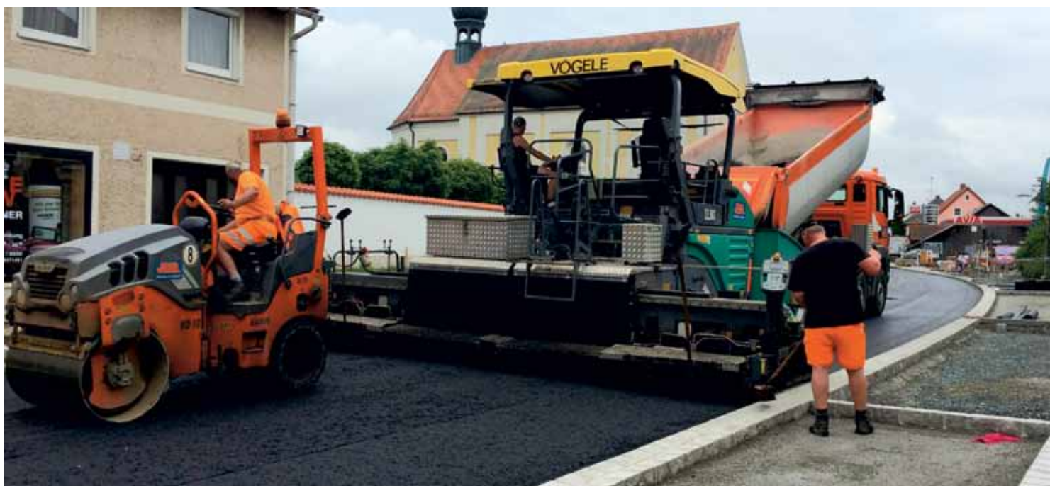
Sanierung Ortsdurchfahrt Rötz
