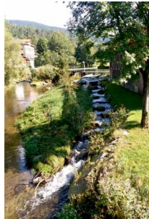
Fischwanderhilfe in Form eines Raugerinne-Beckenpasses, errichtet an der Wasserkraftanlage Hohenwarther Mühle am Weißen Regen
