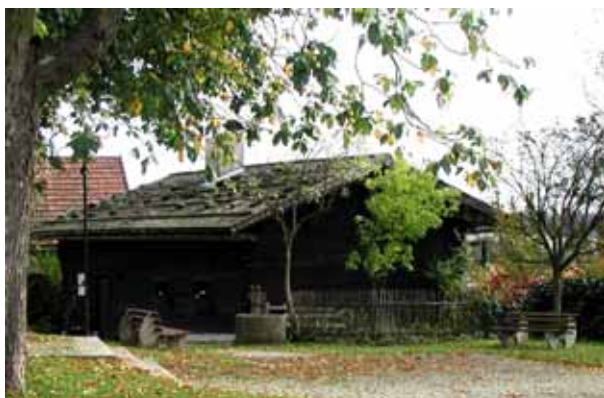
Unterrichtsraum und Lehrerwohnung unter einem Dach: das Fronauer Dorfschulhaus von 1860.
