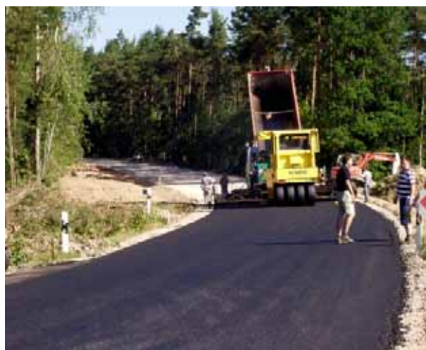
KrStr. CHA 8 Roding – Schorndorf Beseitigung einer unfallträchtigen Kurve
