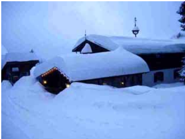
Ein Hotel in der Gemeinde Lohberg. Ein romantisches Bild – wäre da nicht die Gefahr eines Einsturzes gewesen, die durch die Feuerwehren beseitigt werden musste.
