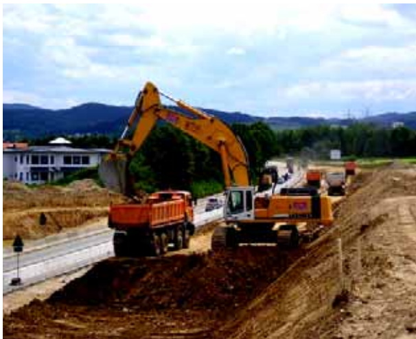
Erdbaustelle auf der B 85
