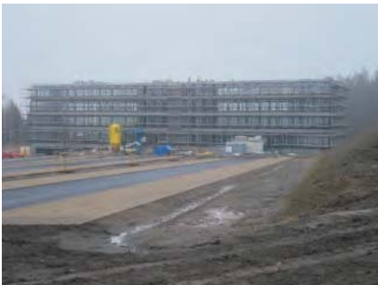
Neubau eines Bürogebäudes mit Logistik und Produktionsflächen durch die Continental Mechanical Components Germany GmbH in Roding
