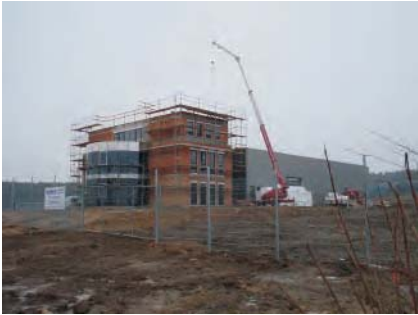
Neubau einer Lagerhalle mit Bürogebäude durch die Firma Elektroanlagen Schwarzfischer GmbH in Roding
