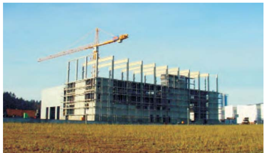
Neubau einer Produktionshalle für Hochdruckschläuche in Weiding durch die Firma Rädlinger primus line, Cham
