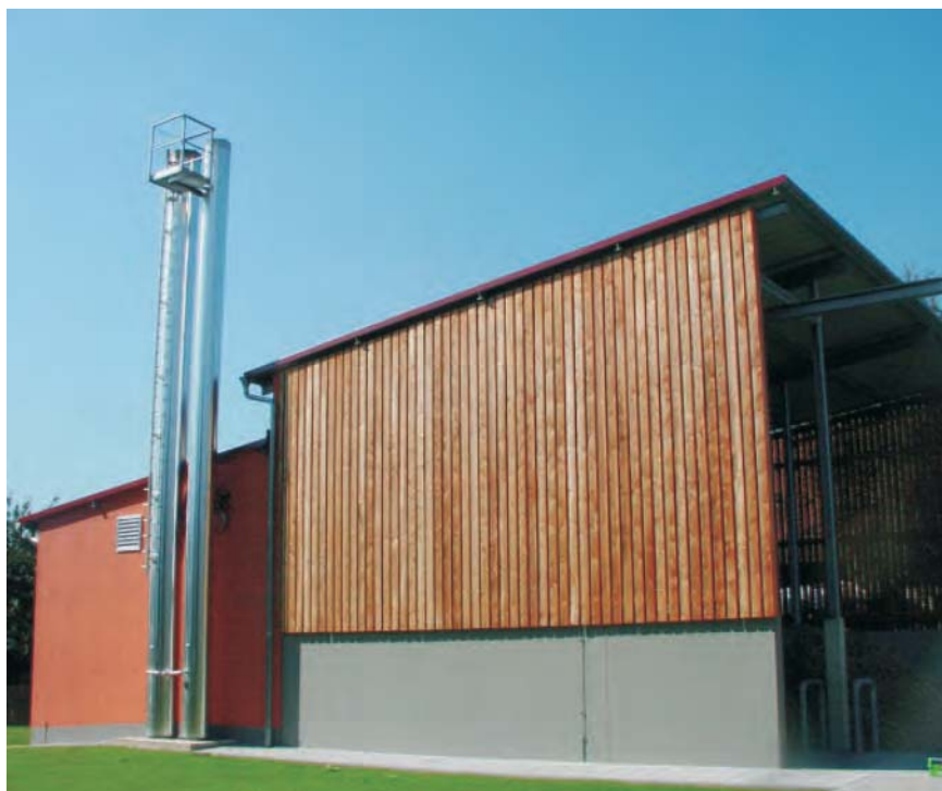
Biomasseheizwerk der Bayerwaldwärme Bad Kötzting
