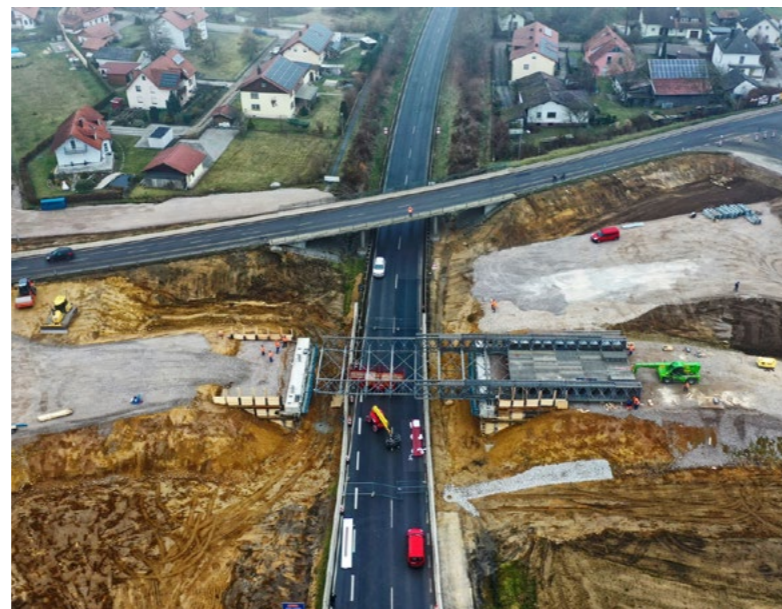
2-bahniger Ausbau bei B85 Roding • Bilder: Josef Kerscher
