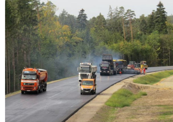
Straßenneubau im Landkreis Cham
